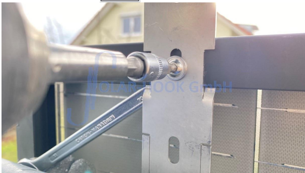
Abb. 16/Anziehen der kurzen Schrauben
