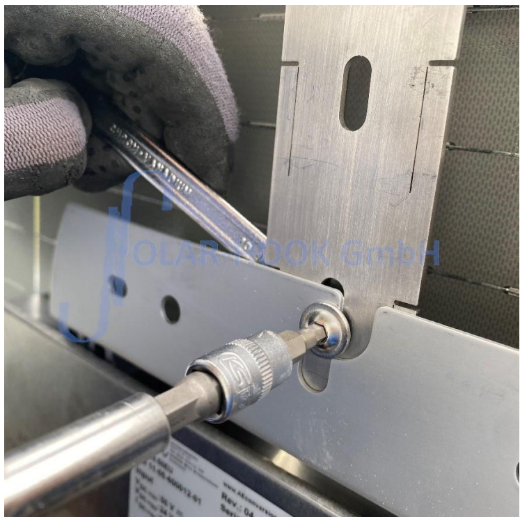
Abb. 6/Wechselrichter am SOLAR-HOOK Befestigungsbügel anschrau- ben
