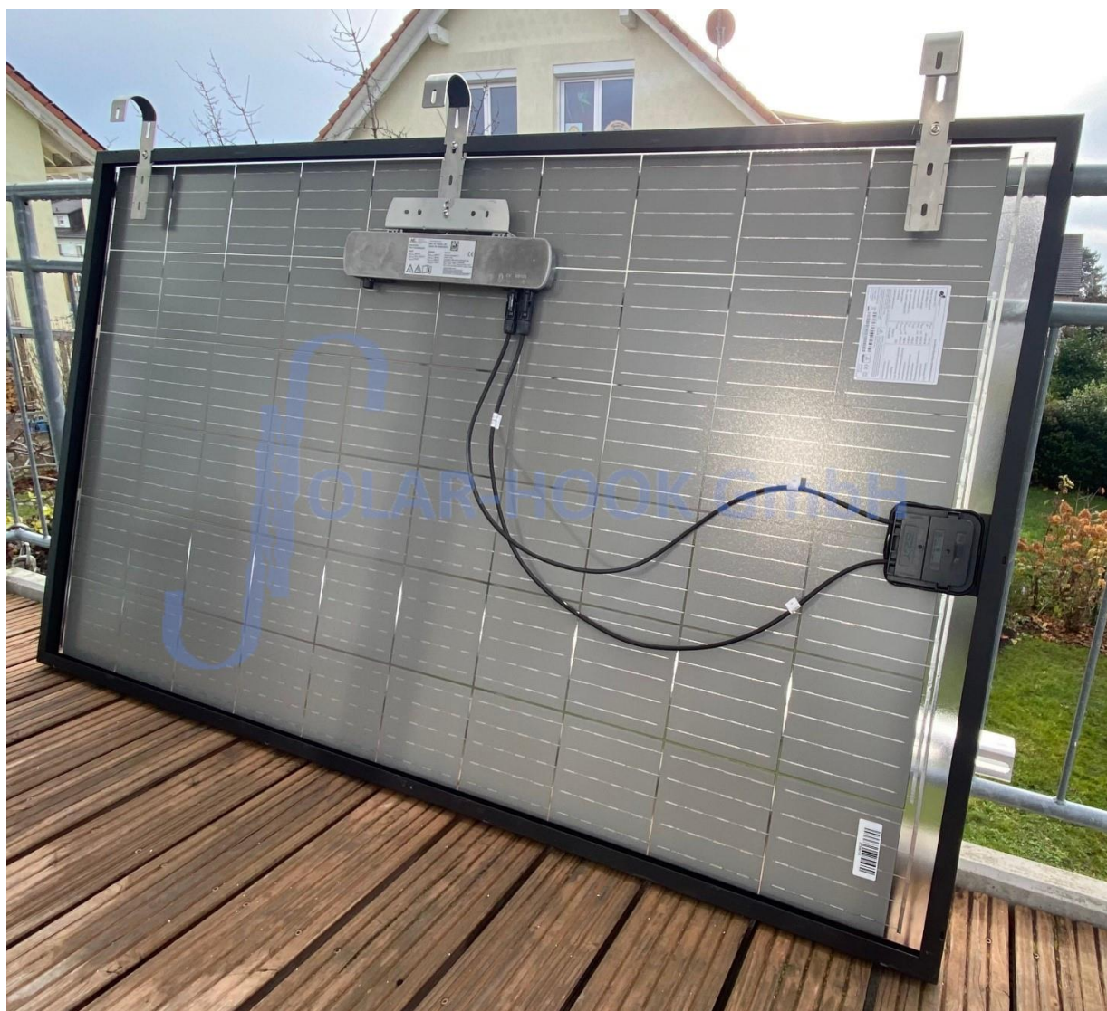
Abb.7/vorbereitetes Solarmodul mit 3 Befestigungsbügeln und Wechselrichter
