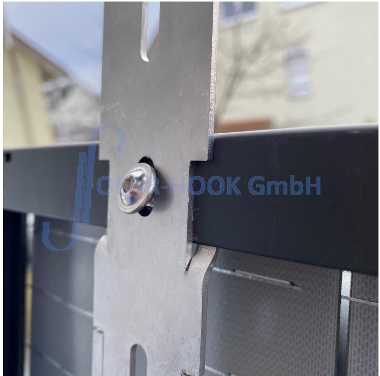
Abb. 5/locker angesetzte Schraube M6 kurz
