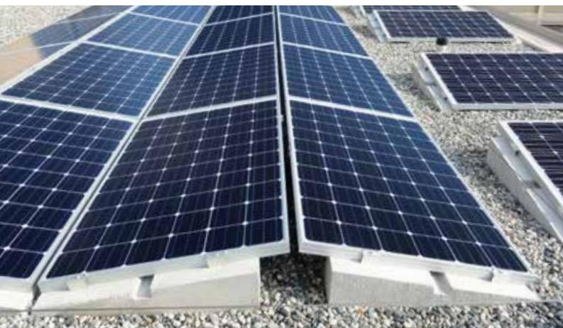
Wenn Sie den Widerstand noch weiter erhöhen wollen gibt es auch die Möglichkeit, benachbarte Vorschaltgeräte mit speziellen Verbindungsplatten zu verbinden, um die Stabilität der gesamten Struktur zu verbessern. Diese Art der Ausrichtung
